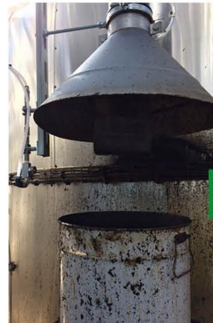
Neutralisierung von Emissionen bei der Lagerung von Asphalt bei hohen Temperaturen – Entgasung der Tanks. Düsen zur Dosierung des chemisch aktiven Präparats.
