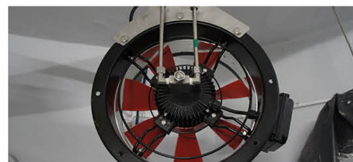
Dozowanie preparatu do zanieczyszczonej przestrzeni za pomocą wentylatora.
