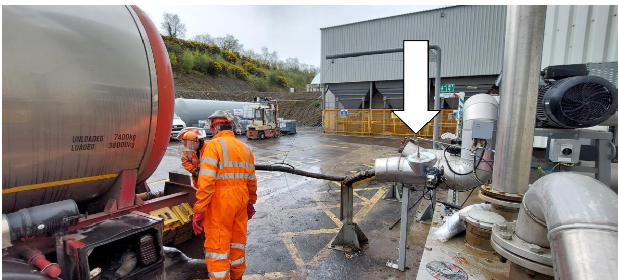
Podczas roztankowywania cystern asfalt jest automatycznie neutralizowany. Dysze dozującą preparat INHITONE wskazuje biała strzałka. Zdjęcie z firmy ROADSTONE pod KILLARNEY, Irlandia.
